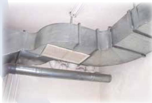
*Figure 7: Système d'évacuation des vapeurs d'autoclave, Bulgarie, 2003*
